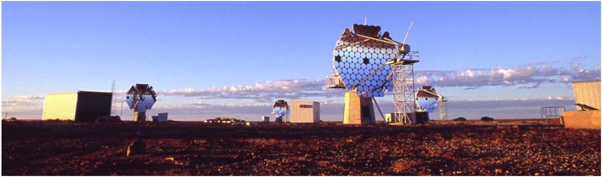
図1 オーストラリア・ウーメラのカンガルー望遠鏡。4台の口径10m望遠鏡からなる。
